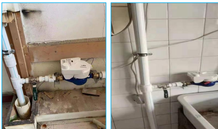
居民水表更换
